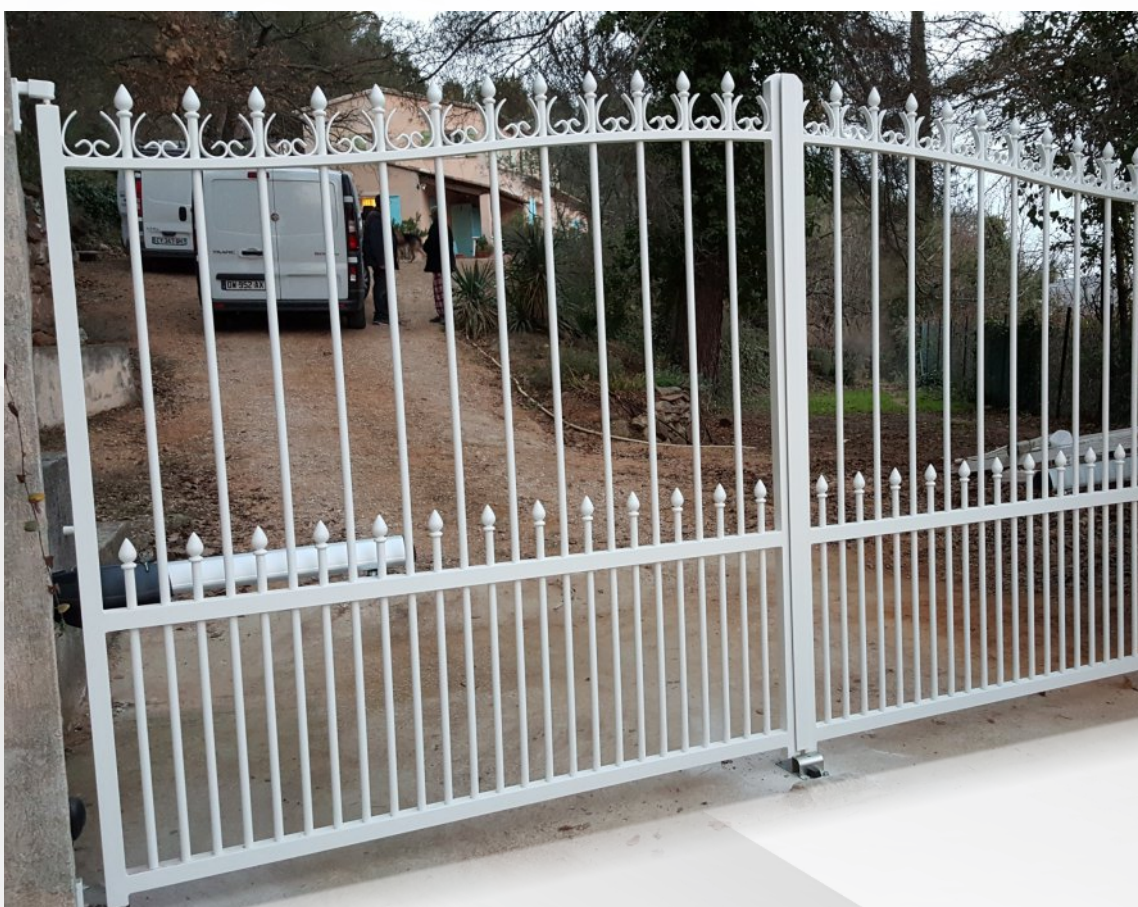
► Portail battant Vitry modifié, traverse haute en forme CDG avec fers-de-lance n°4, avec rangée de petites volutes. Soubassement avec double barreaudage comprenant rangée de fers-de-lance dans la traverse intermédiaire. Sabot de sol métallique en option.
