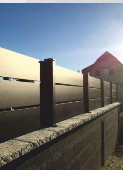
Poteau d'angle avec tube 30x30 à sceller
