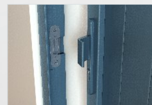
Gâche électrique et poignée de tirage extérieur
