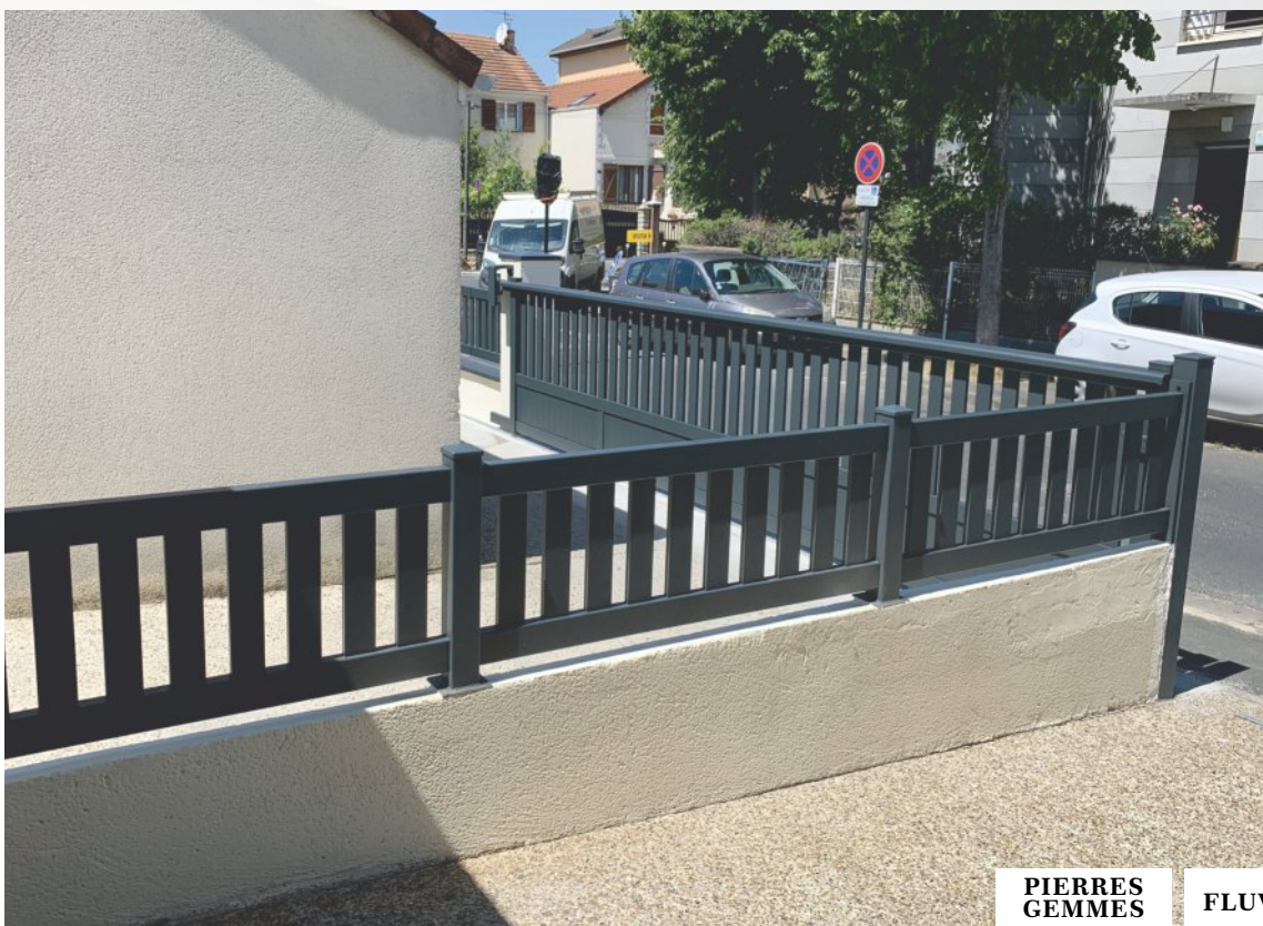
► Clôture barreaudée à panneaux, barreaux 80x20 ajourés.
